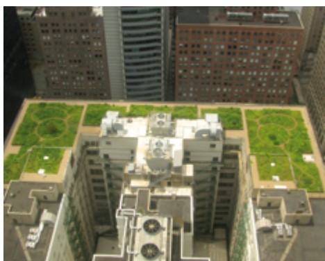
Figura 139. Cubierta intensiva accesible en el Chicago City Hall, EEUU.
