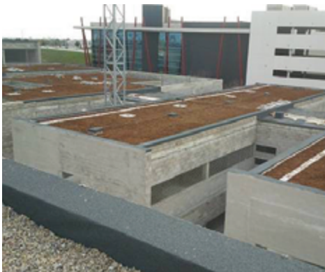
Figura 182. Proceso constructivo de la cubierta vegetal del edificio Parc Bit, Palma de Mallorca.
