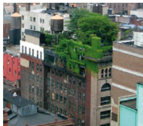
Figura 141. Cubierta en Manhattan, EEUU.
