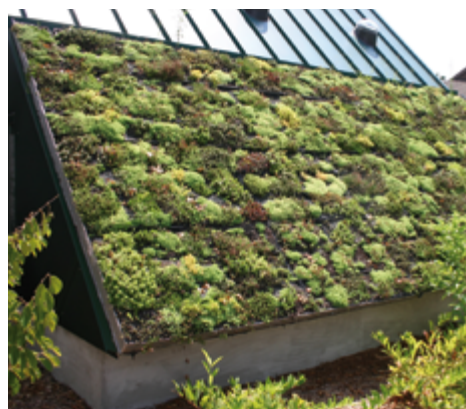
Figura 140. Cubierta intensiva inclinada.
