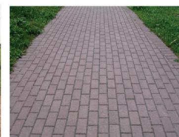
Adoquín de hormigón
