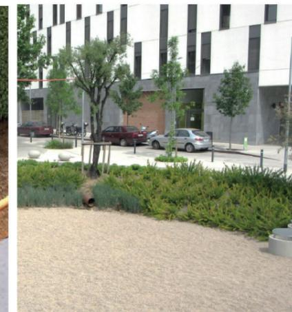
Depósito de detención en superficie
