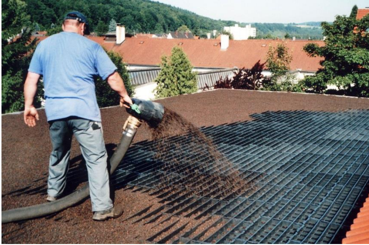
Cubierta realizada in situ. Fuente: Core roof.
