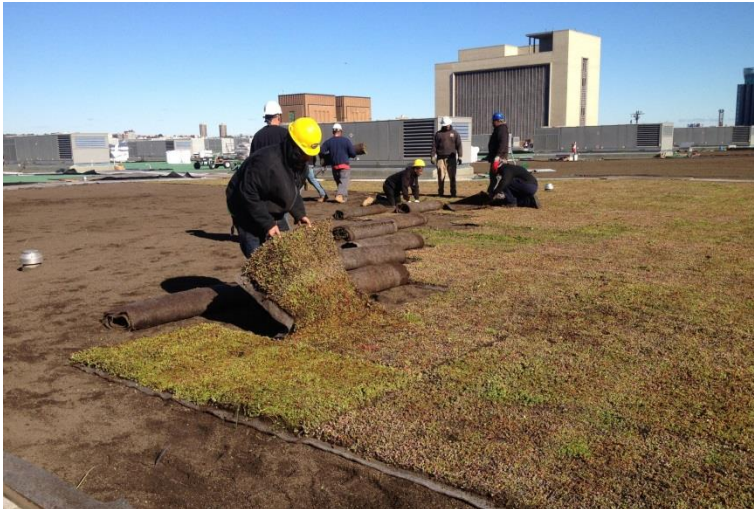
Cubierta de tepes de sedum. Fuente: Umich.
