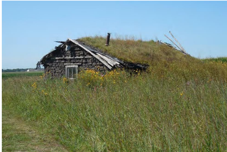
Cubierta vegetal en una vivienda de turba en Estados Unidos. Fuente: Pearl, J.
