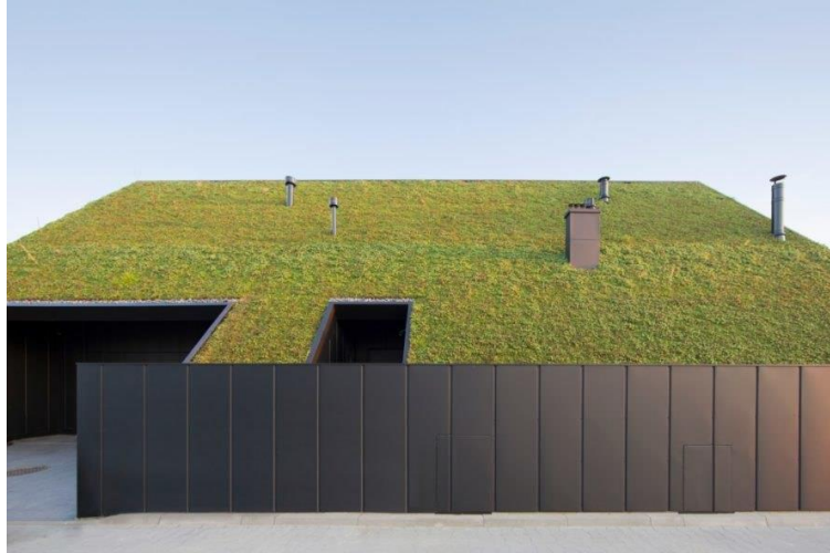
Cubierta inclinada a 45º Superhelix, Cracovia, Polonia. Fuente: Bartłomiej Drabik
