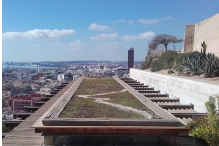
Cubierta verde extensiva. Restaurante La Ereta. Alicante. Fotografía: autor.
